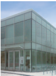
Fujitsu General (UK) Co., Ltd. (UK)
